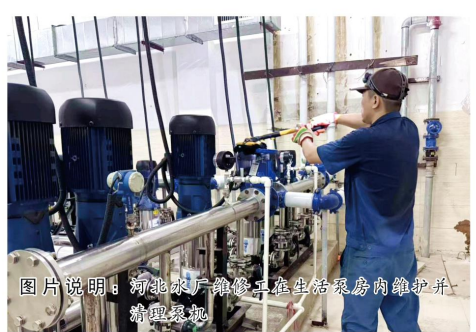
图片说明：河北水厂维修工在生活泵房内维保并清理泵机
